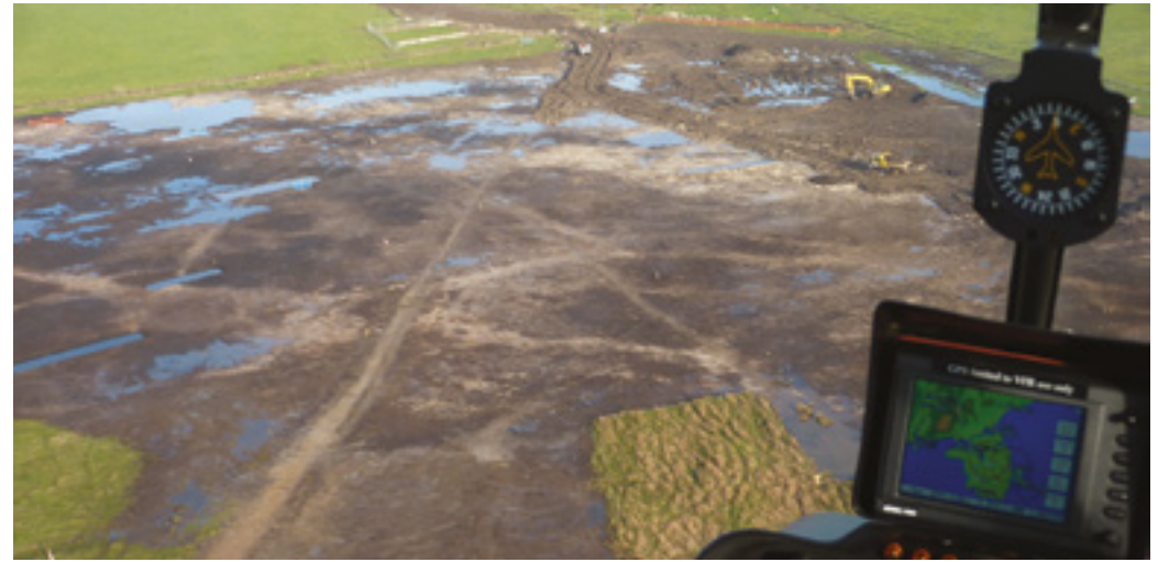
Golwg o'r awyr o waith a oedd yn cael ei wneud yng Nghae Gwyn yn 2011. Roedd y gwaith cloddio mawn enfawr hwn yn ymestyn dros dir o faint oddeutu 13 cae pêl-droed a dyma'r prosiect adfer coryydd alcaliaidd mwyaf yn y byd.
